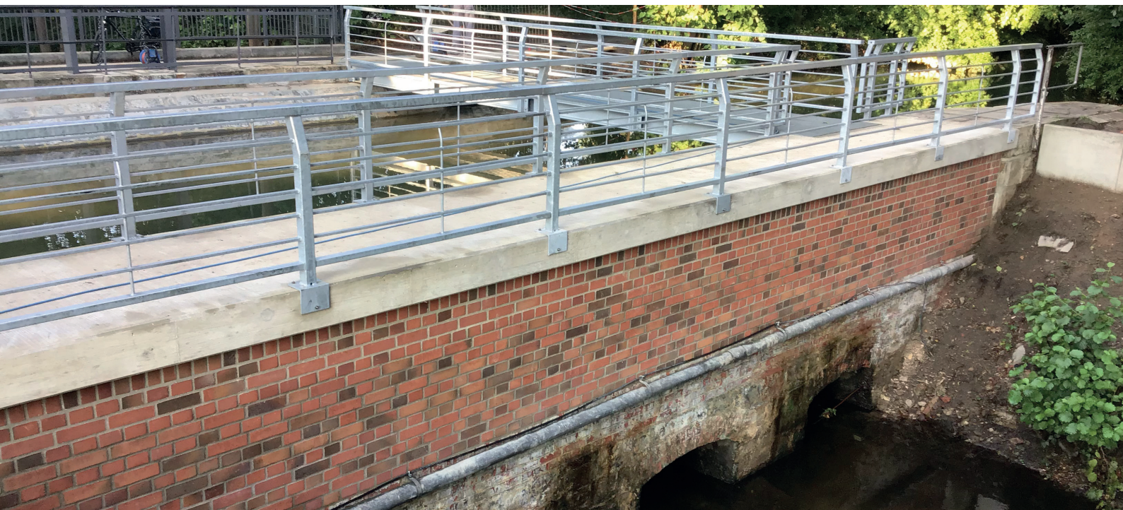
Abb. 09 | Foto, Unterquerung Thune - Boker Kanal (vgl. STADT PADERBORN, 2018)
