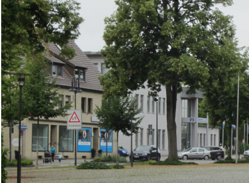
Bebauung an der Von-Ketteler-Straße
