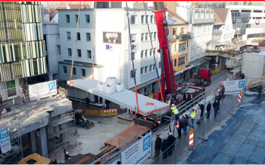
Montage der ersten Natursteinbrücke
