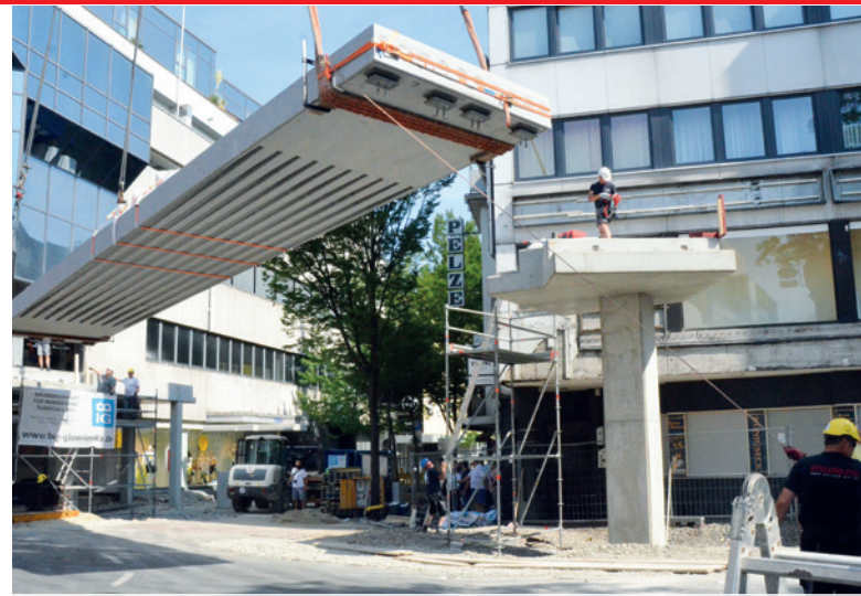
Einbau der Brücke im Kreuzungsbereich Marien- und Königstraße
