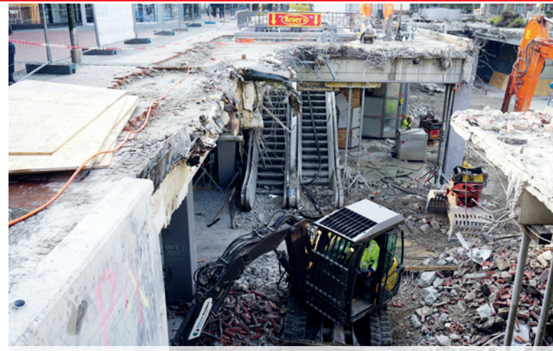
Abriss für den neuen Königsbalkon im September 2016
