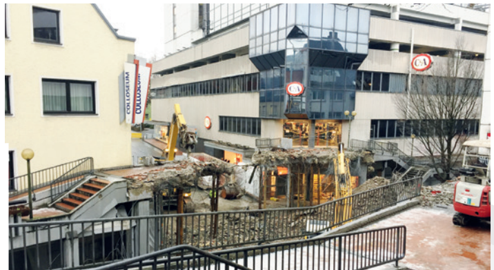
Abriss der Brücken in der Marien- und Königstraße
