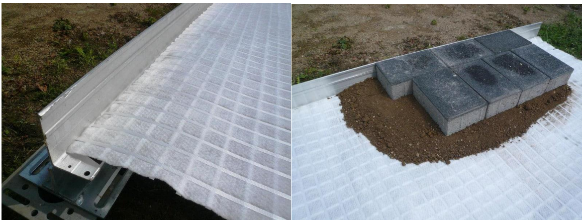
Darstellung der möglichen Einbausituation bei den Platanen
