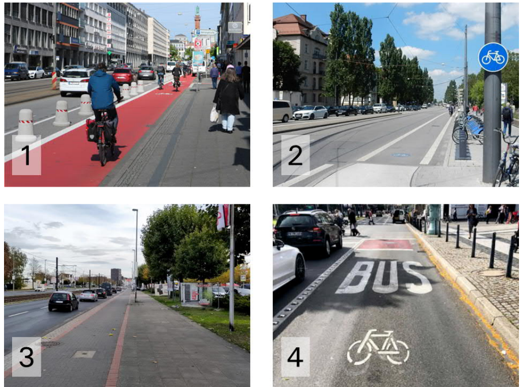
Abb. 109 Vorgestellte Radverkehrsführungen in der Befragung: (1) Geschützter Radfahrstreifen („Protected-Bike-Lane“), (2) Radfahrstreifen, (3) Getrennter Geh- und Radweg, (4) Bussonderfahrstreifen mit Freigabe für den Radverkehr („Umweltstreifen“)
