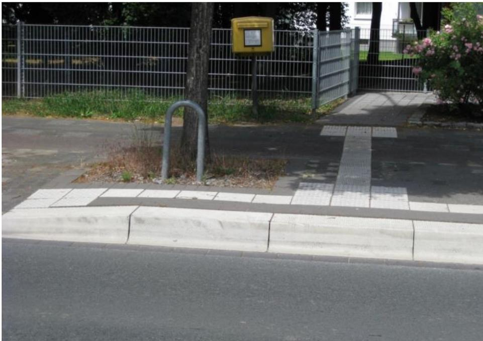
Abbildung 18: Bodenindikatoren nach aktuellem „Stand der Technik“: Aufmerksamkeitsfeld aus Noppenplatten, Einstiegsfeld aus Noppenplatten und Leitstreifen aus Rippenplatten (Beispiel: Haltestelle Technisches Rathaus)
