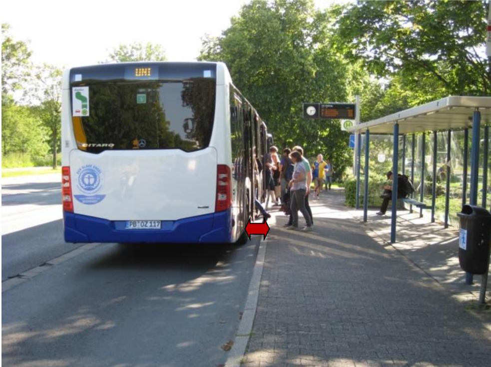
Abbildung 15: Busbuchten mit zu kurzer Ausbildung ermöglichen kein spaltfreies Anfahren der Haltestellenkante (Beispiel: Haltestelle Uni Südring; Situation Juni 2014 vor dem Umbau)
