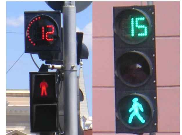
Abb. 66: dynamische Restrotanzeiger
