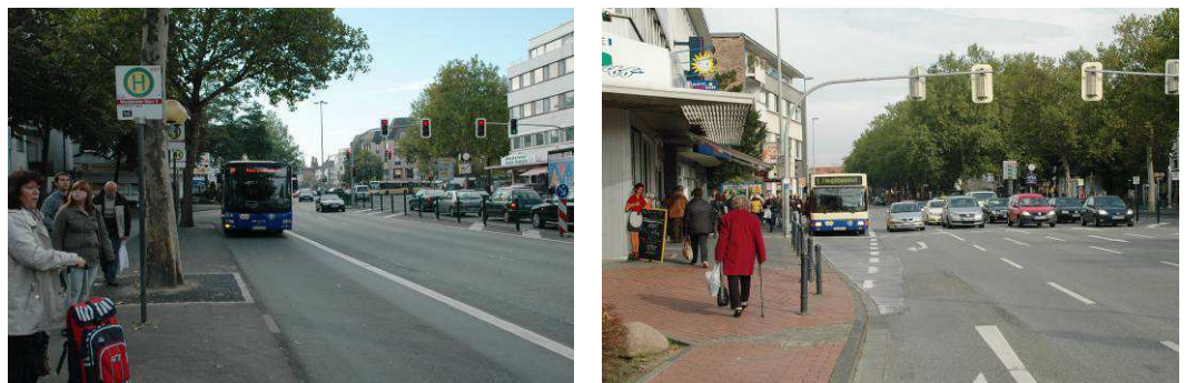
Abb. 13 Haltestelle Westerntor: Zaun zur Verhinderung des Überquerens (links); Haltestellenkante auf der Westseite der Friedrichstraße („Spur3“, rechts)
