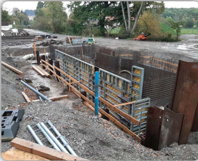
Innenansicht Rückhaltebecken 3.750 mm / 2.000 mm
