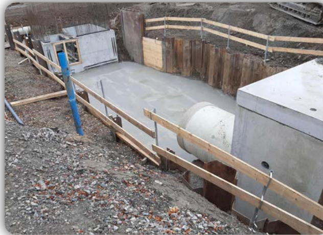
Bau der Erweiterung des RÜB
