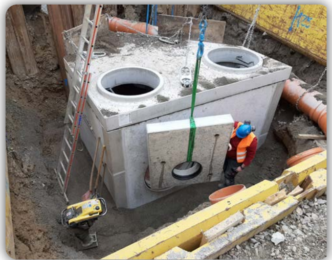
Herstellung eines Schachtbauwerkes im Bereich Alter Hellweg / Wasserburg (Kirche)
