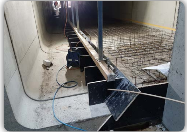
Bau der Abschlagleitung zur Alme 3.250 mm / 1.000 mm
