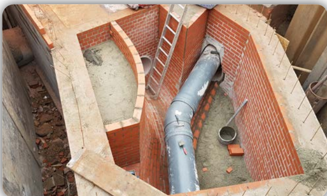
Im Bau befindliches Schachtbauwerk mit prov. Durchleitung
