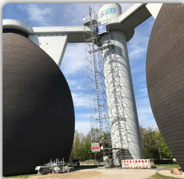
Faulbehälter und eingerüsteter Treppenhausturm
