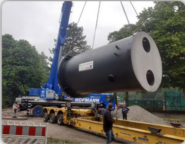
Einbau eines Pumpenschachtes bei der Baumaßnahme Fürstenweg
