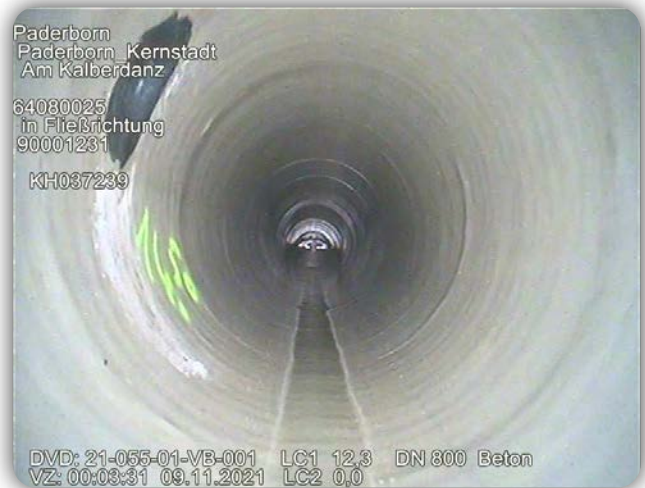
Kanal nach Schlauchliniersanierung
