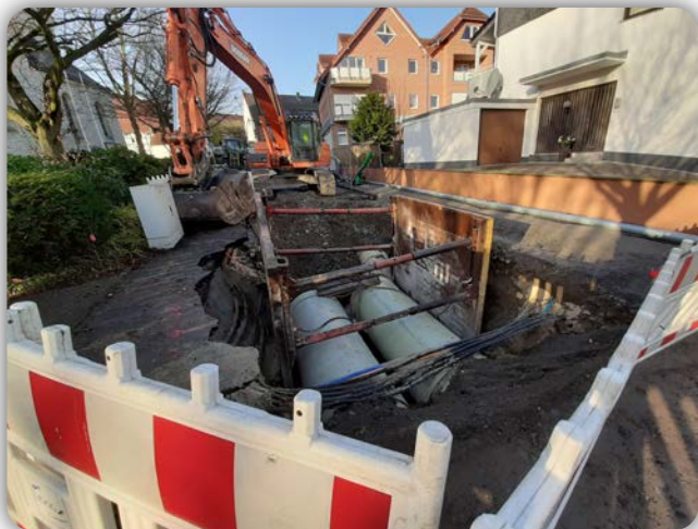
Zuleitung zum RÜB über zwei Mischwasserkanäle DN 1.100
