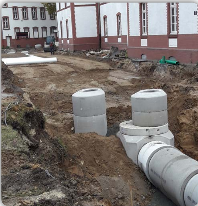
BA, Quartier Denkmalbereich, Rohrgraben Trennsystem, SW-Kanal DN 250, RW-Kanal DN 1.000
