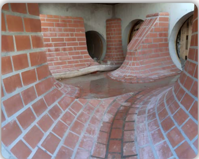
Herstellung eines Schachtbauwerkes im Bereich Alter Hellweg / Wasserburg (Kirche)
