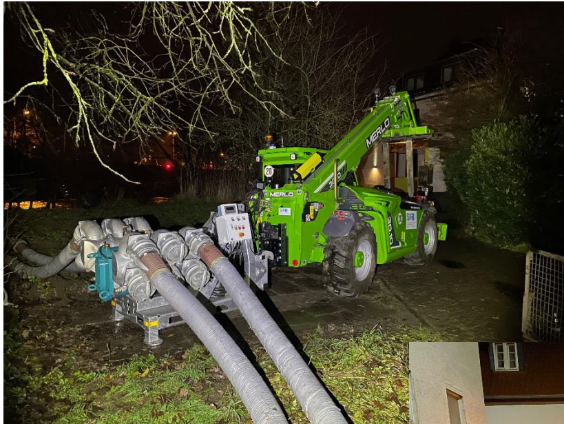
24.12.2023, 1:28 Uhr, Schloß Neuhaus, Cäcilienstraße, Überpumpen Binnenentwässerung mit Hochleistungspumpe
