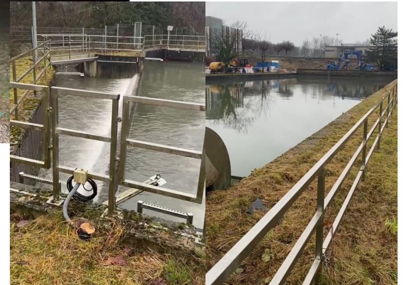
25.12.2023, 11:15 Uhr, RÜB Ottilienquelle (V~10.000cbm), Überlauf der Regenüberlaufbecken / des Bodenfilters in die Pader
