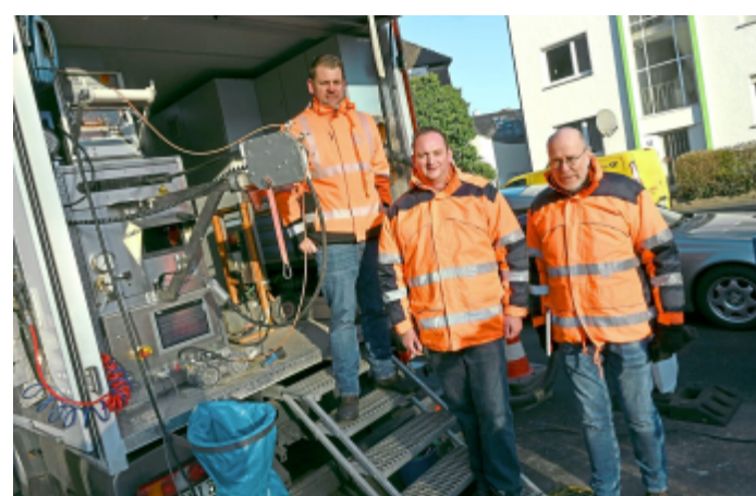
Bauleiter Korbinian Festing sowie Christian Fengler und Hubertus Schmidt (von links) vom Stadtentwässerungsbetrieb erläutern die anstehenden Arbeiten am Kanal. Im Mai soll das Projekt zwischen Gierswall und Heierswall abgeschlossen sein. Foto: Ingo Schmitz
