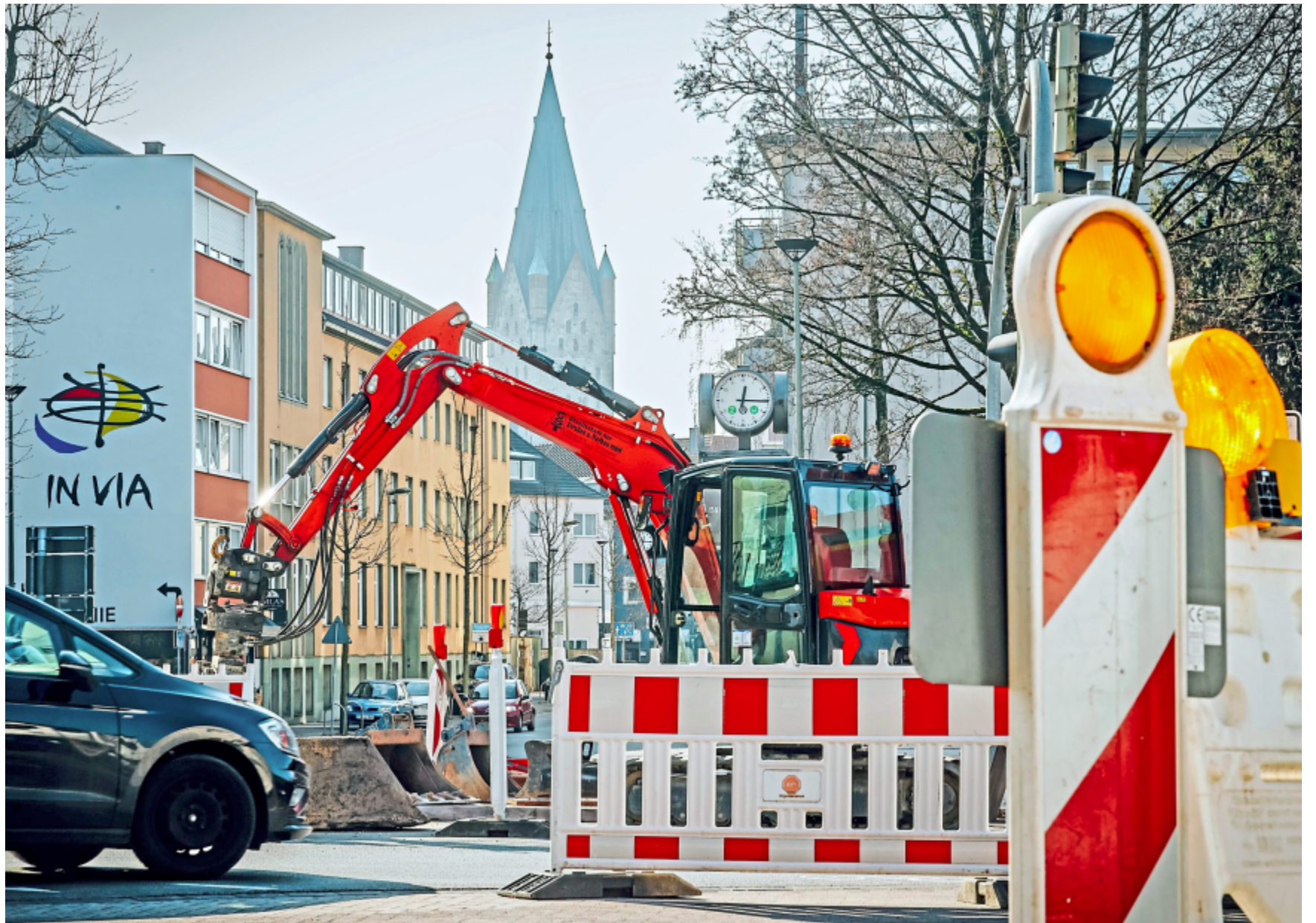
Am Gierswall laufen aktuell Kanalarbeiten. Der Bereich zwischen Driburger Straße und Detmolder Tor (Foto) wird im April für rund sechs Wochen komplett gesperrt. Foto: Jörn Hannemann
