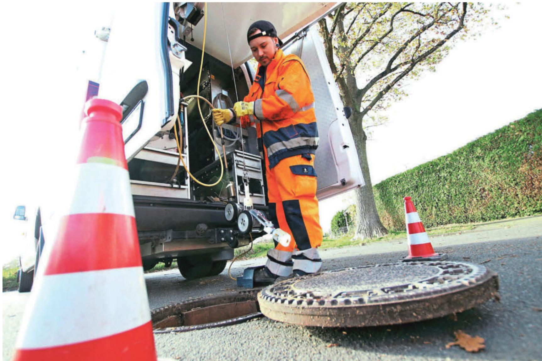
Justin Harting seilt eine Kamera in einen Regenwasserkanal im Von-Dript-Weg in Marienloh hinab.
