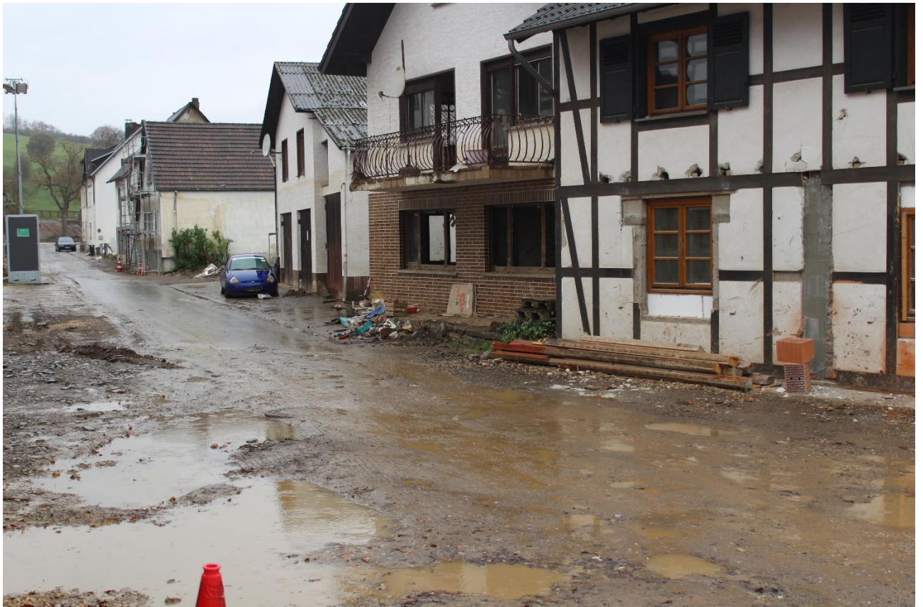
Ein typischer Anblick, der sich den STEB-Mitarbeitern im Ort Schuld bot. Selbst der Balkon hat sich unter Wasser befunden.
