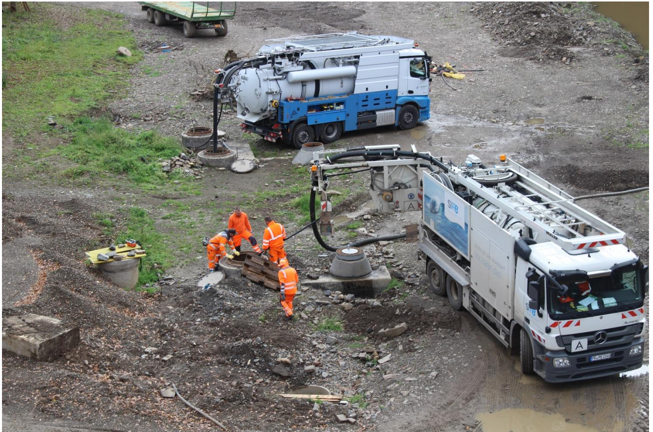
Die STEB-Mitarbeiter zusammen mit Kollegen aus Mannheim beim Reinigen von Kanälen, die vor der Katastrophe unter einer Straße lagen.
