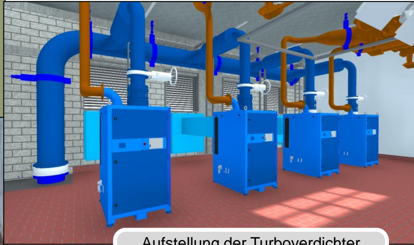
Aufstellung der Turboverdichter und Druckluftleitungen in der Verdichterstation
