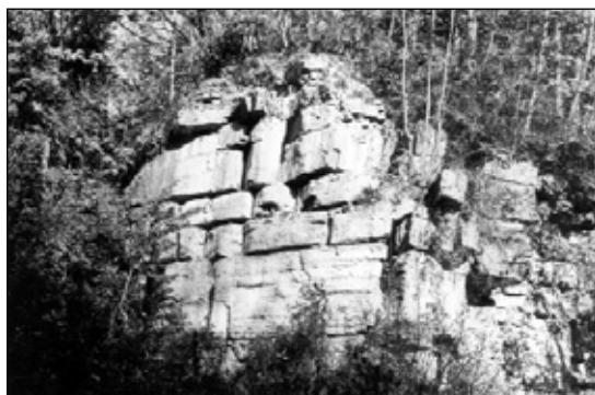
Abb.9: Kalkbänke des Cenoman in nahezu planer Lagerung, durch senkrechte varistische und herzynische Klüftung gespalten und beim Abbau zu Quadern zerfallend; Zustand Herbst 2008.
