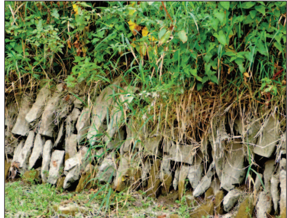
Abb.9: Uferbefestigung der Alme aus Packlagesteinen, 13.09.2014
