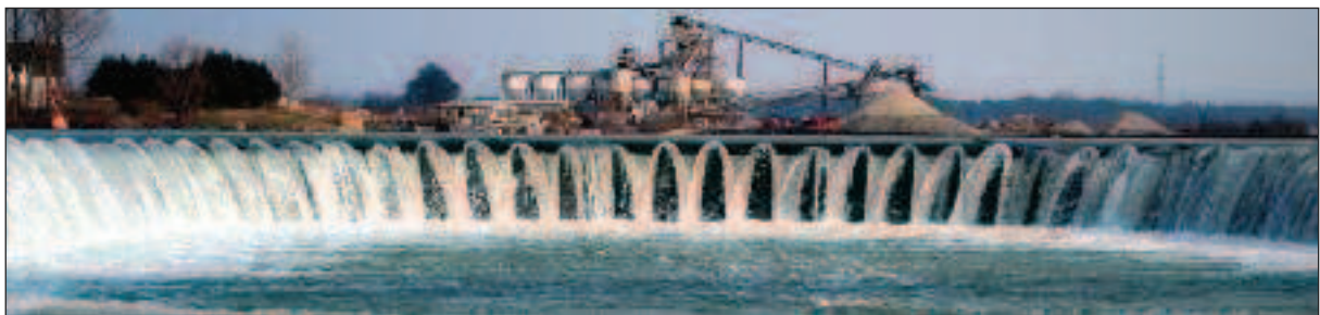
Abb. 1: Auslaufbauwerk des Lippesees (im Hintergrund das Kieswerk am Nordufer des Sees)
