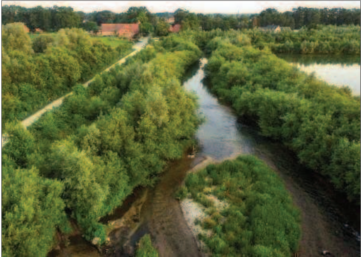
Abb.13: Blick von Norden auf die Umflut zwischen Nesthauser Grundsee und Hochwasserentlastungsdamm (im Hintergrund der Hof Neesen)
