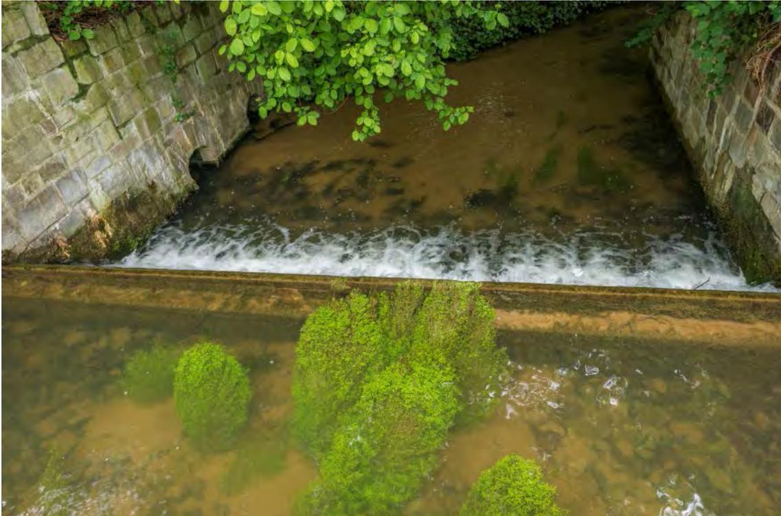
**Abb. 37: Schwellen wie hier an der Masperspader halten den Wasserstand in den Quellbecken künstlich hoch**
